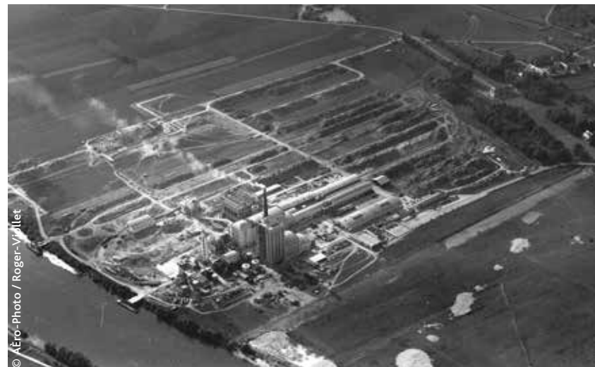
Ancienne usine Novacel à Alizay (Eure)
